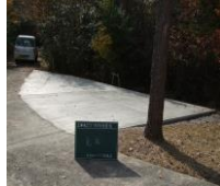
④駐車場整備
